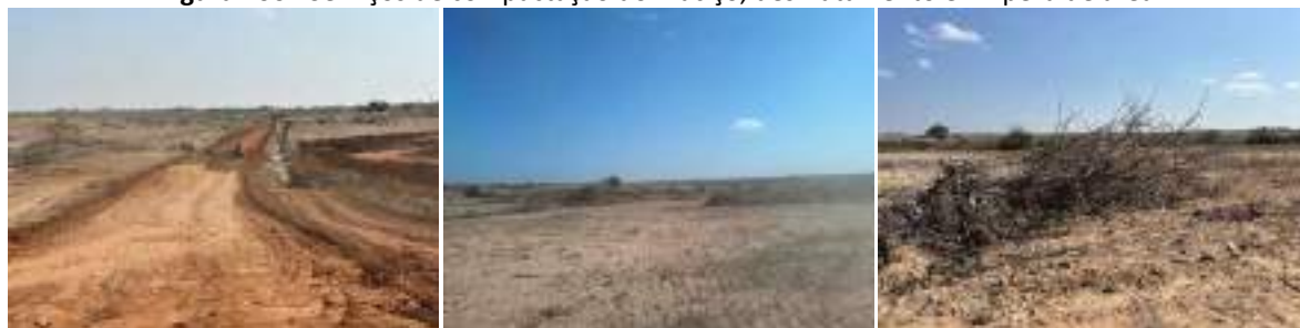
Compactação da fundação do maciço
