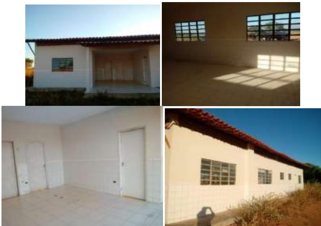
Fonte: Fotos do acompanhamento disponíveis no sistema Obras 2.0/Simec
