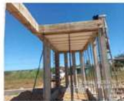
Figura 3 Construção do ginásio de esporte.
