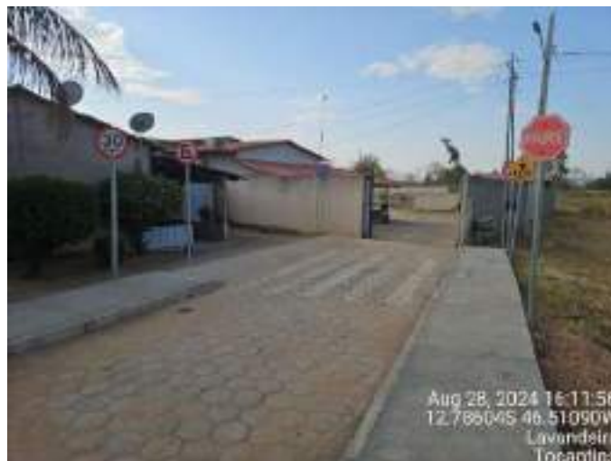
Figura 81: Final da "Rua Acesso Posto" pavimentado.
