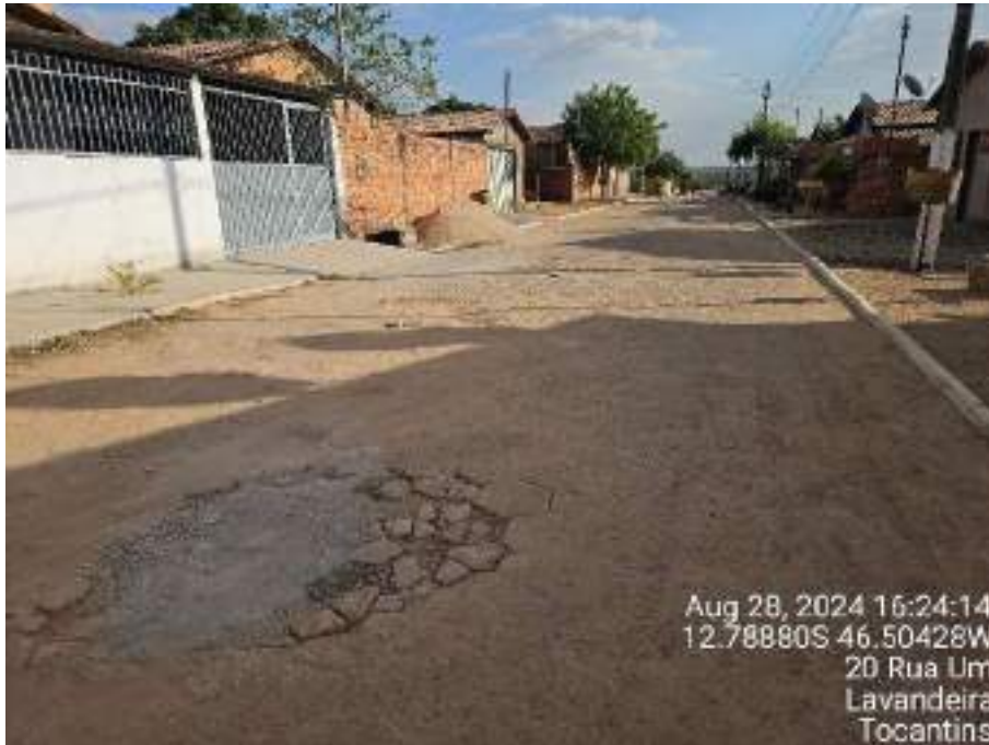
Figura 73: Rua 01 não pavimentada com TSD.
