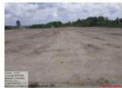
Fonte: Registro fotográfico do local de execução acostado no Transferegov.br
