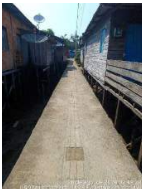
Passarela em Concreto
