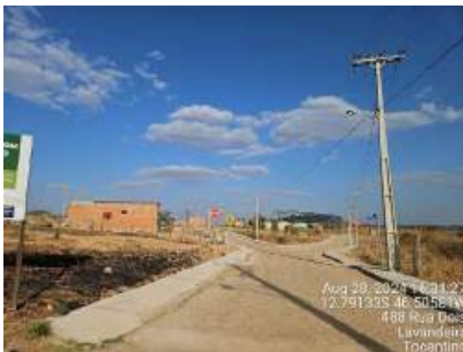
Figura 82: Início do trecho da "Rua SD Três".
