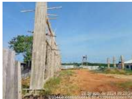
Estrutura de Concreto Concluída
