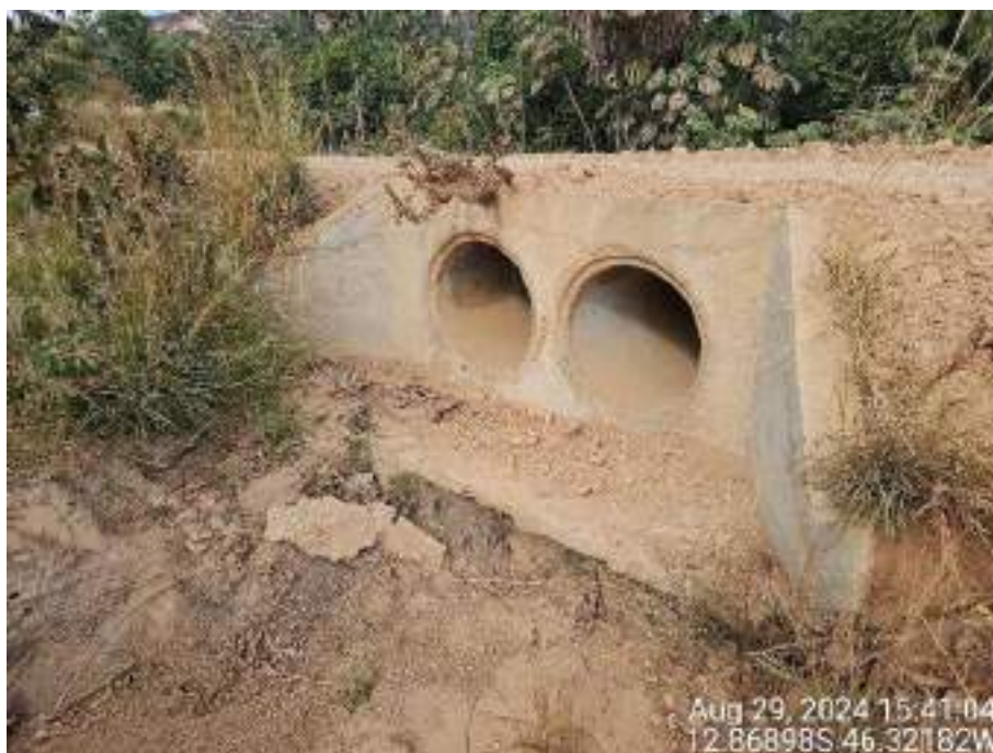
Figura 68: Registro fotográfico de bueiro duplo executado.
