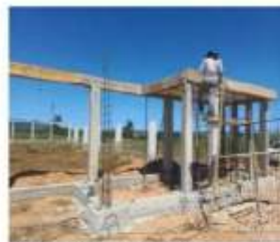
Figura 3 Construção de ginásio de esporte.
