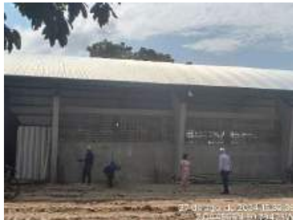
Vista lateral do Ginásio
