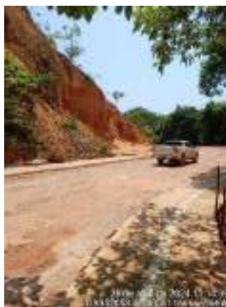
Base revestida com lama asfáltica.
