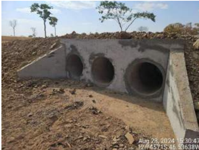
Figura 89: Registro fotográfico de bueiro triplo tubular de concreto.
