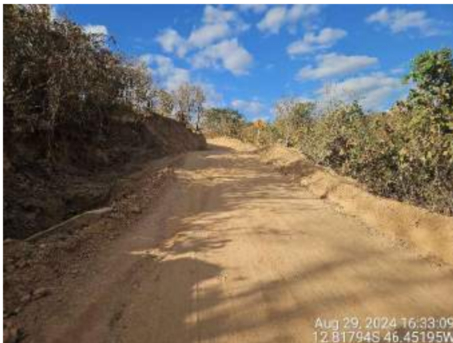
Fonte: Elaboração própria. Vistoria realizada pela CGU.
