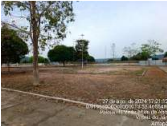
Calçadas executadas e grama faltante
