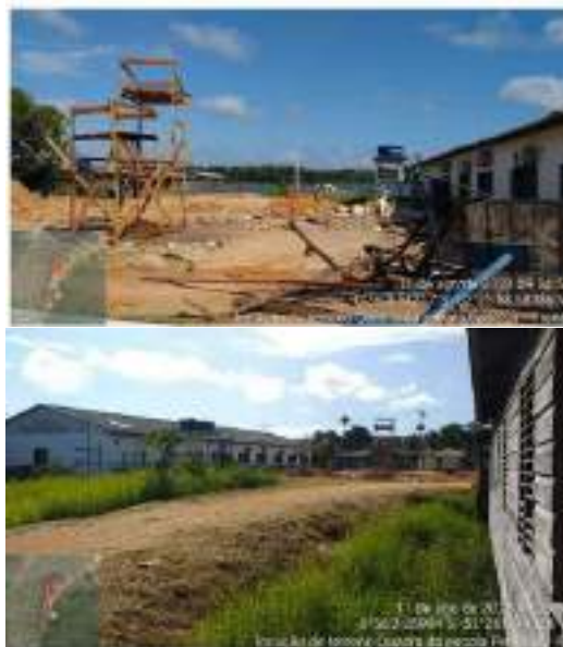
Fonte: Relatório fotográfico obra transferegov.br
