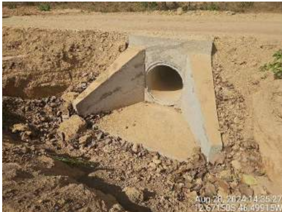
Figura 87: Registro fotográfico de bueiro simples tubular de concreto.
