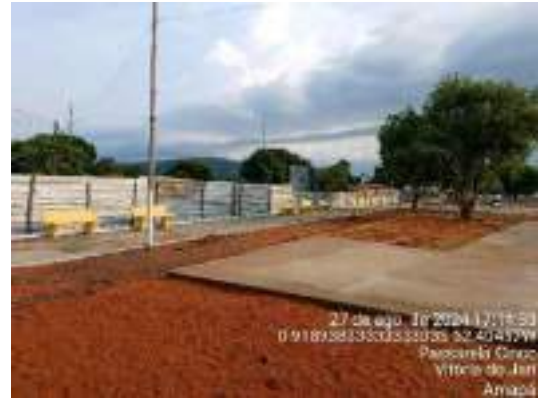
Visão de serviços em execução
