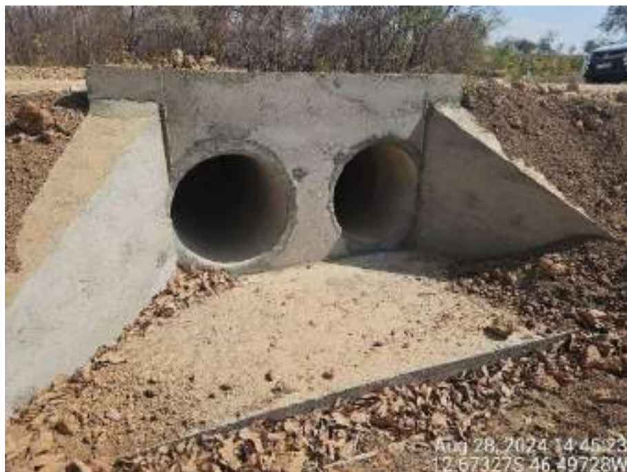
Figura 88: Registro fotográfico de bueiro duplo tubular de concreto.
