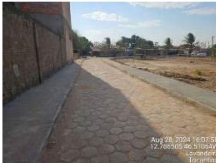
Figura 80: Trecho da "Rua acesso posto" pavimentado.
