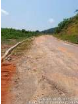
Detalhe da base protegida com lama asfáltica – Trecho-1
