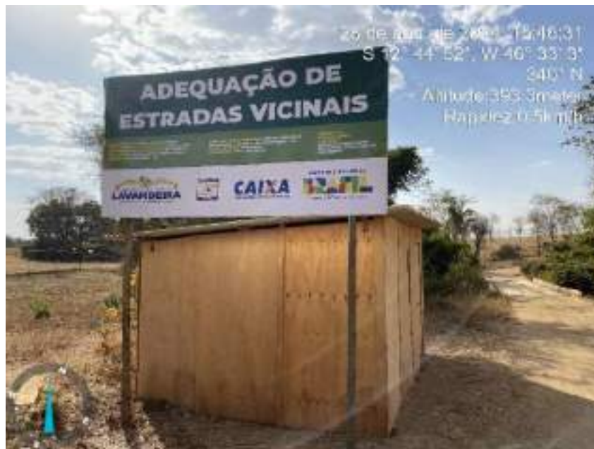
Figura 90: Registro fotográfico da placa da obra, barracão e da ponte que será substituída por outra de concreto.
