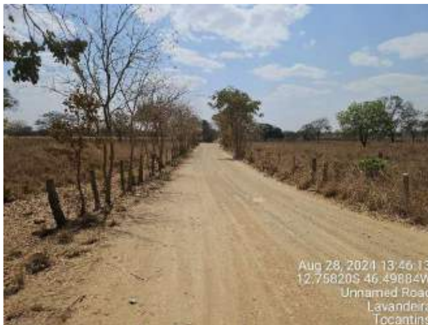
Figura 85: Trecho da estrada vicinal recuperado.
