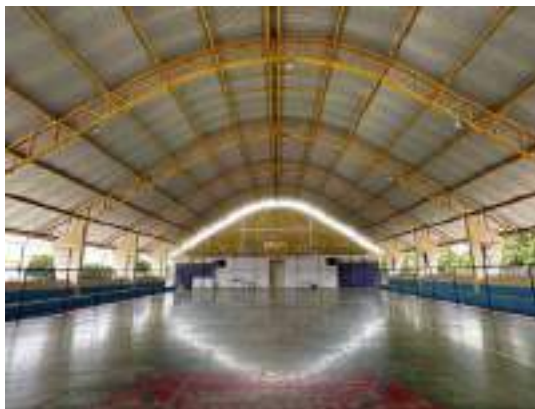
Figura 109: Vista interna da quadra
