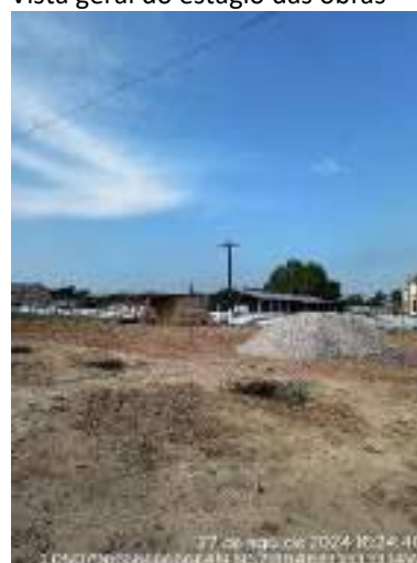
Vista geral do estágio das obras
