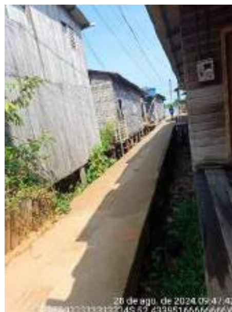
Passarela em Concreto
