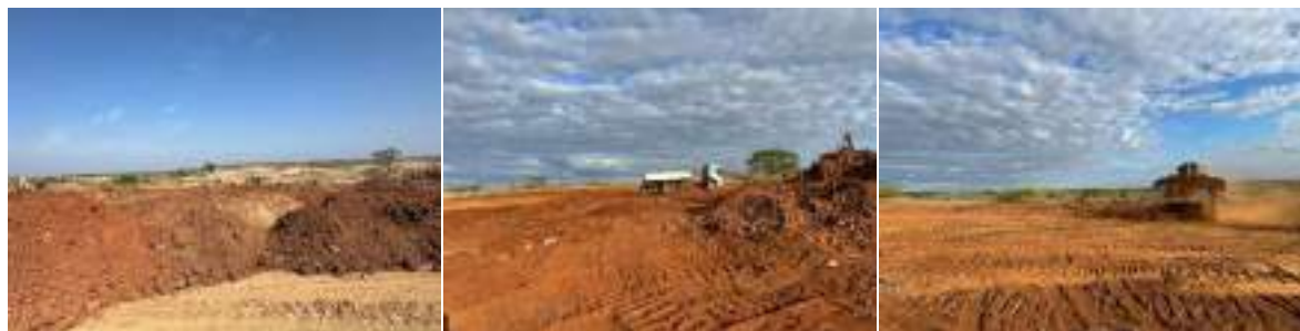
Descarga de material de jazida para compactação
