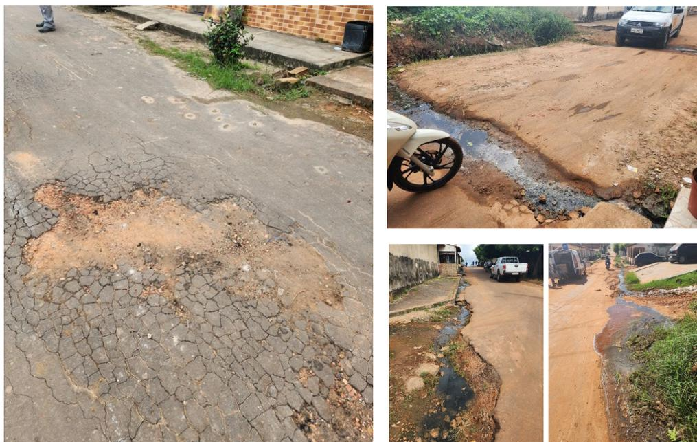
Registros fotográficos da vistoria em Lago da Pedra/MA em 11/05/2023, desagregação do pavimento na rua Alan Sales e fotos diversas da ausência de drenagem/rede de esgoto nas vias pavimentadas.
