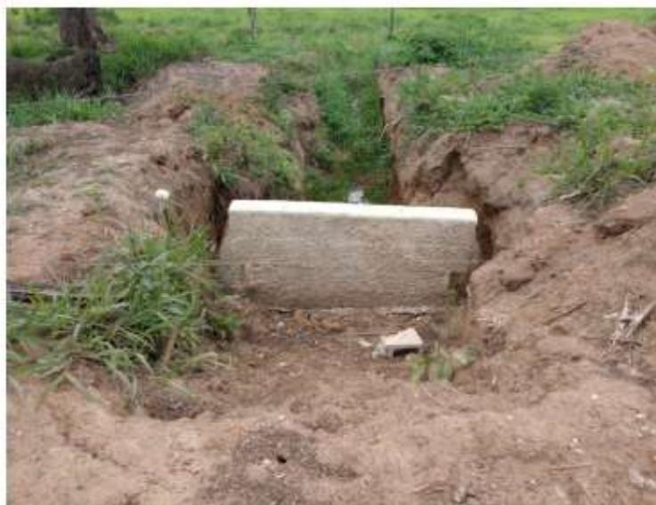
Fotos 13 e 14 – 2,100 - Caixa e ala sem aterro e canal obstruído
