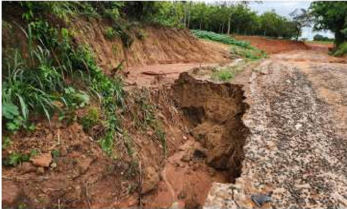
**FOTO 05.** – Início abertura de erosões ocorridas na plataforma ao longo da lançante.
