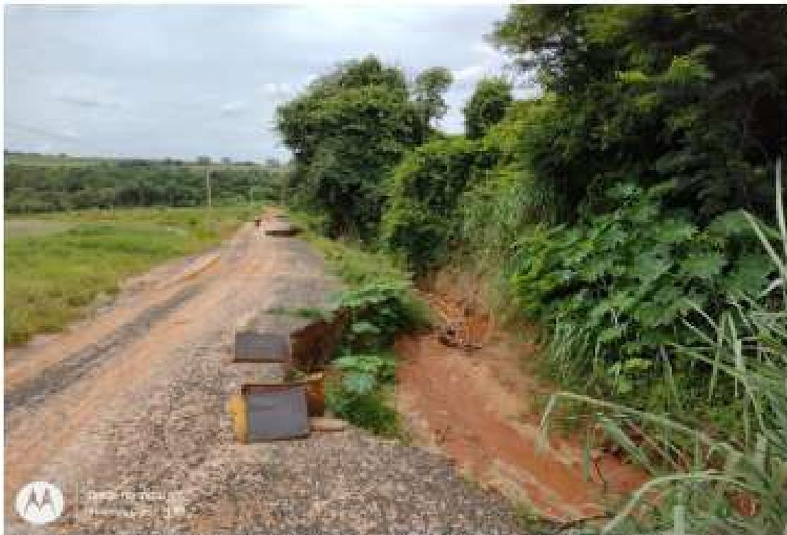
**FOTO 06.** – Sequência de erosões ocorridas na plataforma ao longo da lançante abaixo.
