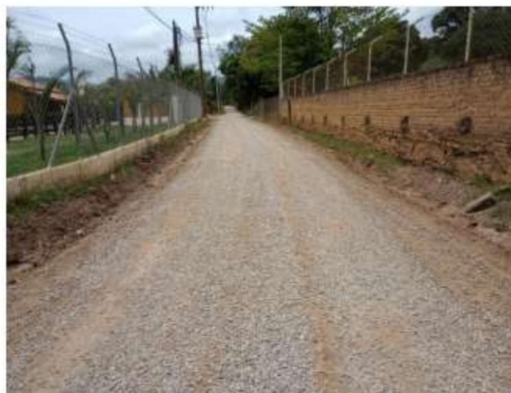
Foto 23 e 24 – 5,100 a 5,400 - Material agregado solto esparramado em cima da pista de rolamento
