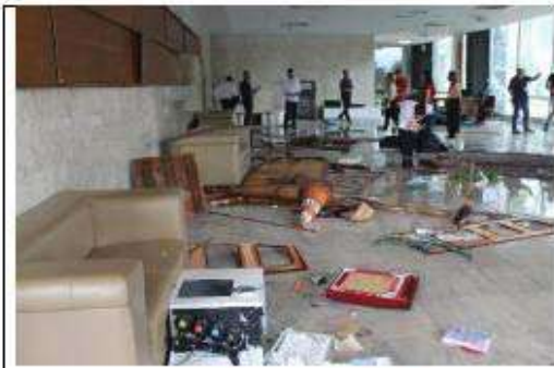
Piso alagado e mobiliário destruído
