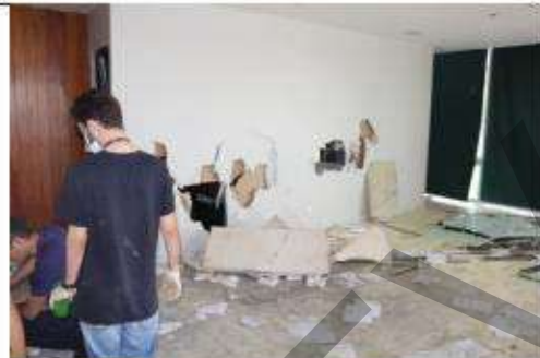
Parede parcialmente demolida
